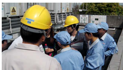
動力供給設備の確認
