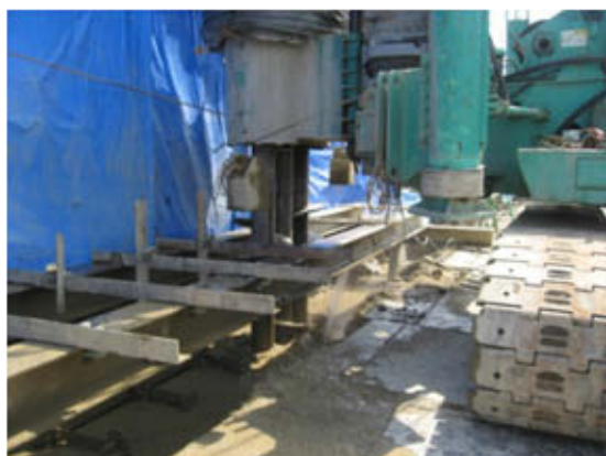
SMW工法施行箇所
