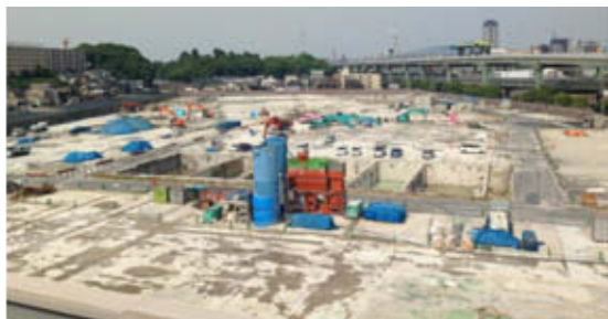
対策工事全容
