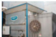
節水に配慮した密閉式冷却塔
