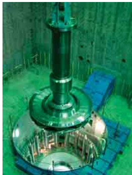
東京電力(株)様 神流川発電所 2号機 水車ランナ吊込み
