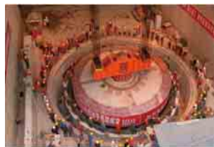
中国向け深溪溝発電所 発電機回転子吊込み
