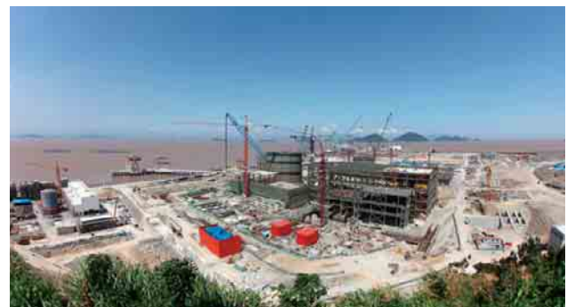
中国浙江省三門原子力発電所 建設風景
