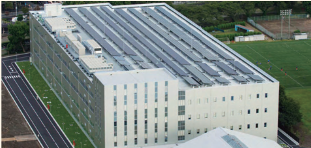
(株)東芝 府中事業所11号研究棟全景
