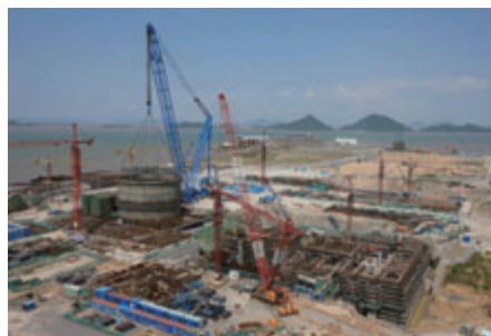
中国浙江省三門原子力発電所 建設風景
