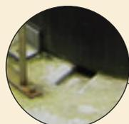
下面漏れ確認用溝の設置
