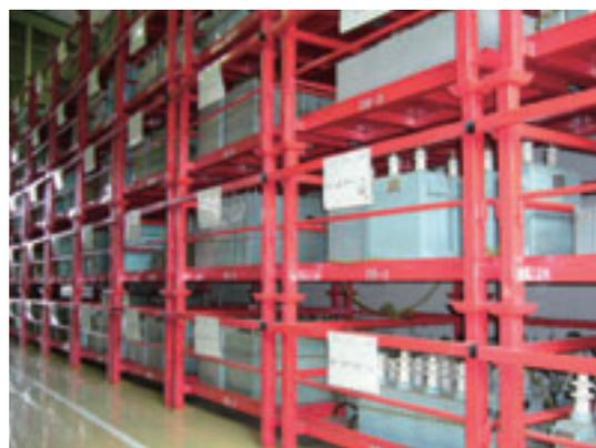
防液堤や二重容器の設置などで厳重に保管したPCB保管倉庫
