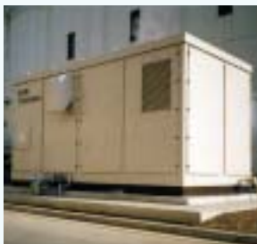
汚泥消化ガス燃料電池 発電システム
