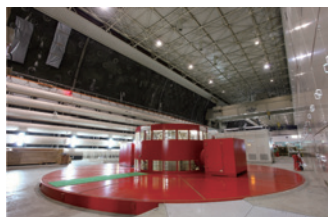
可変速発電電動機 (東京電力リニューアブルパワー株式会社様) Adjustable Speed Generator - Motor (TEPCO Renewable Power, Incorporated)
