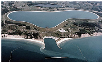
ラディントン 揚水発電所 (コンシューマーズ・エナジー社様 / ディーディー・エナジー社様) Ludington Pumped Storage Power Station (Consumers Energy and DTE Energy Co., Inc.)
