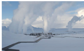
ヘリシェイディ 地熱発電所 (レイキャビクエナジー様) Hellisheidi Geothermal Power Station (Reykjavik Energy)
