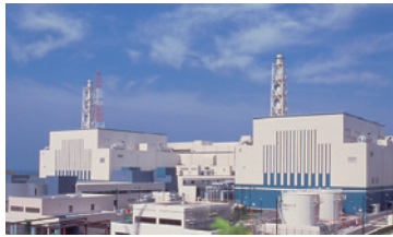
柏崎刈羽原子力発電所6/7号機 (東京電力ホールディングス株式会社様) Kashiwazaki-Kariwa Nuclear Power Station unit No.6 and No.7 (Tokyo Electric Power Company Holdings, Inc.)
